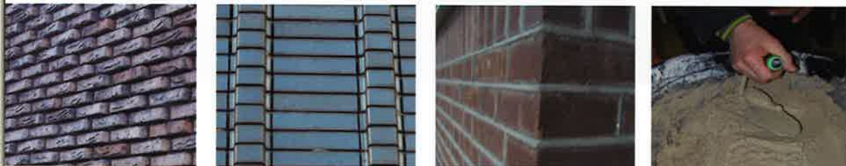
◀ Van links naar rechts Geborsteld doorstrijkwerk, Profielsteen gelijmd, Gekipte voeg in dunbed en de Ergo troffel super prof.
