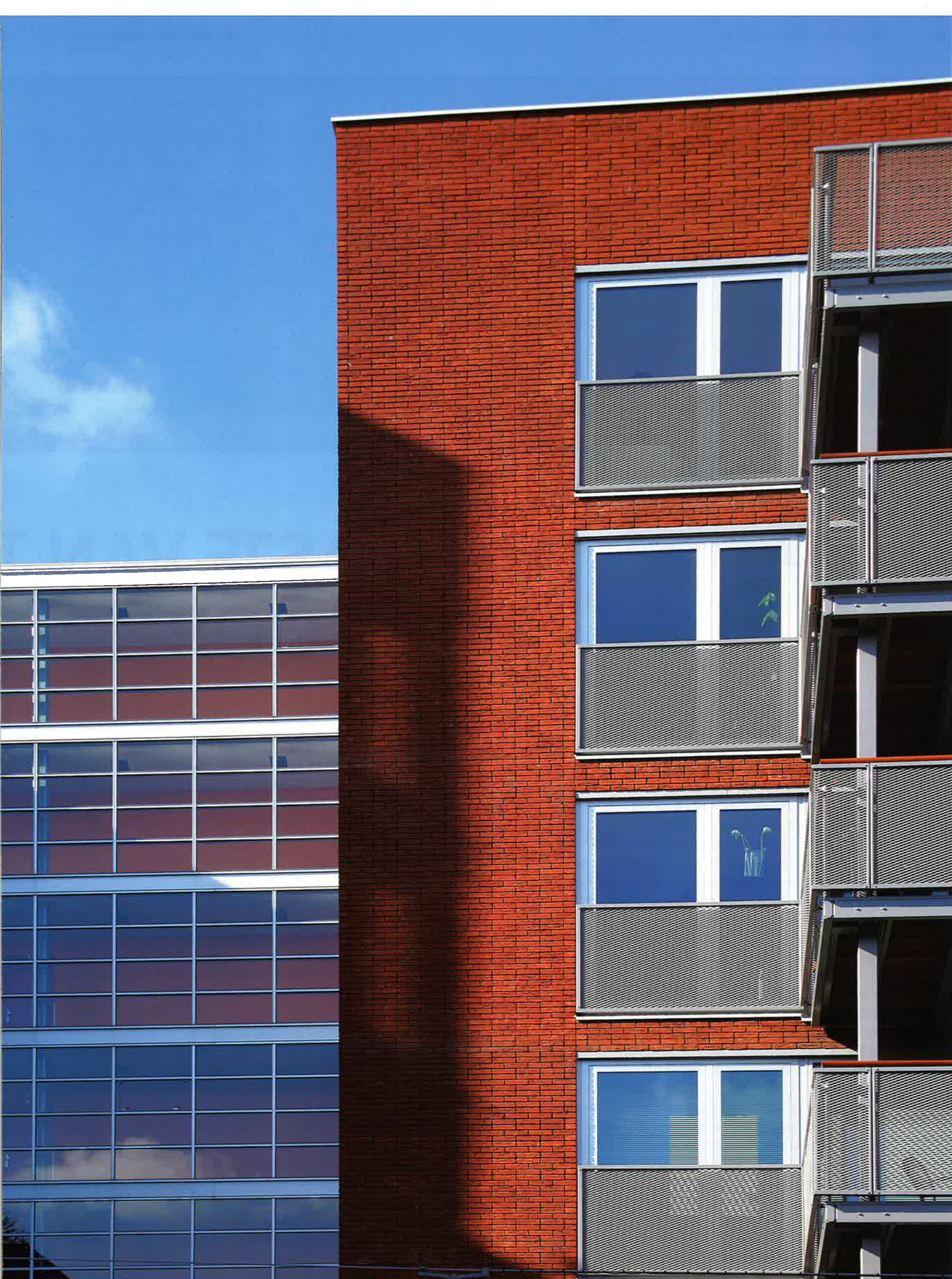
Rabbijn Maarsenplein, Den Haag (Architecten: José Rafael Moneo en Alberto Nicolau, co-architect Claus en Kaan) Foto Pierre Crom
